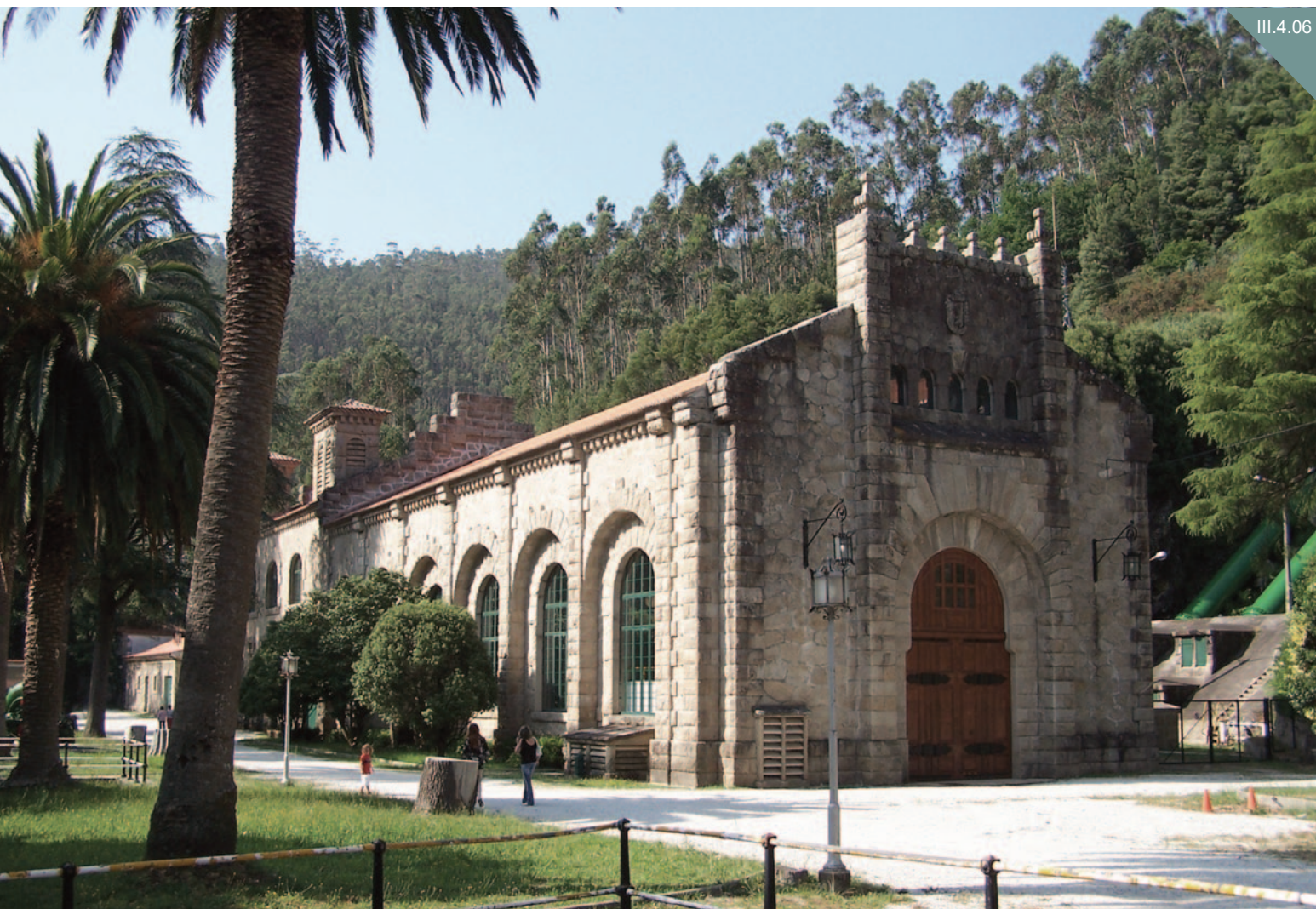
Central hidroeléctrica do Tambre (Noia)
