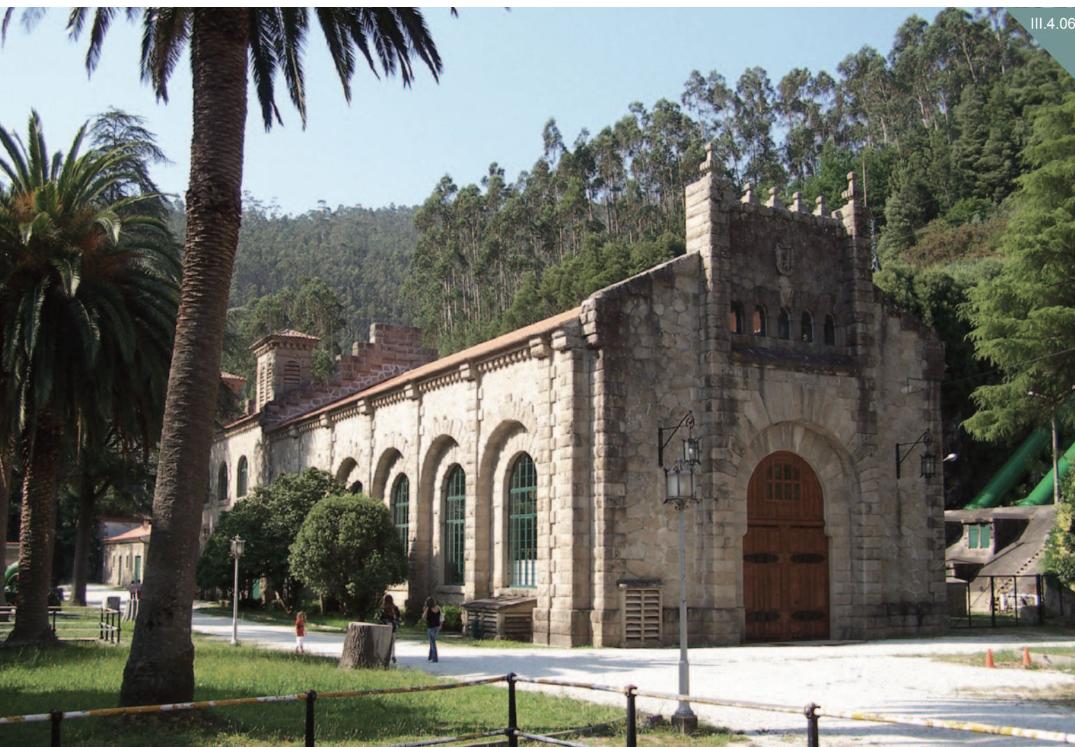
Central hidroeléctrica del Tambre (Noia)
