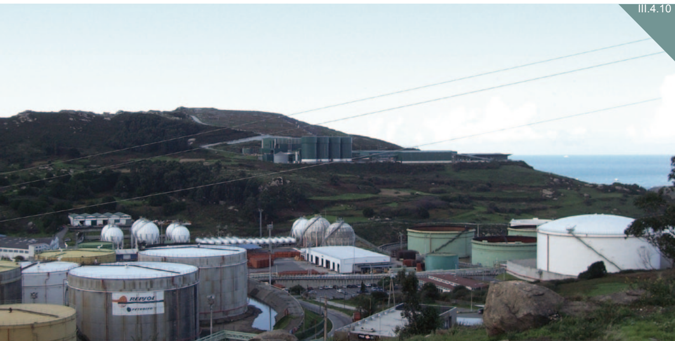
Refinería de Repsol. A Coruña
