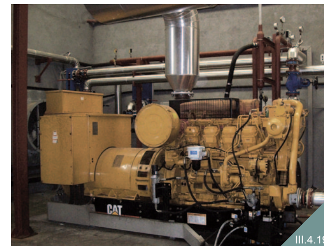
Instalación de cogeneración
