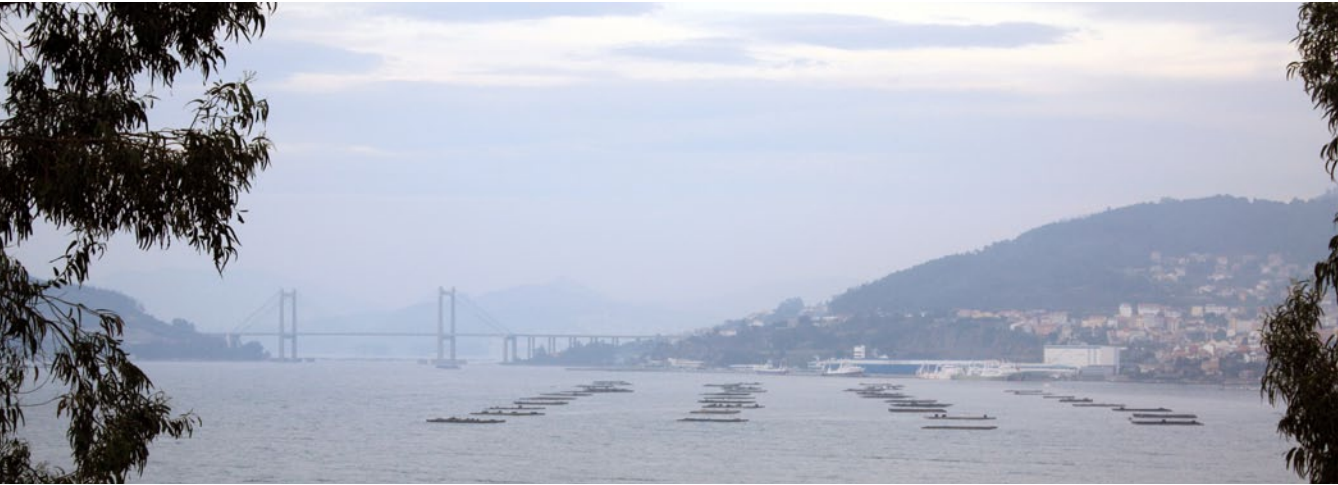
Panorámica del puente de Rande. Ría de Vigo
