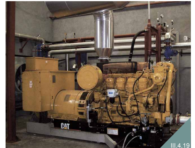
Instalación de coxeración.
