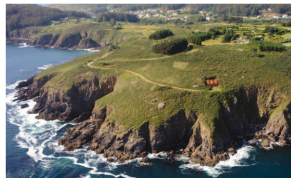
instalación militar en Punta Avarenta
