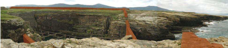
El mismo sistema de protección: el muro.
