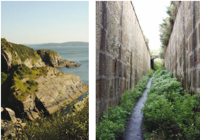
Vista y acceso de los tuneles de la batería de Punta Segaña
