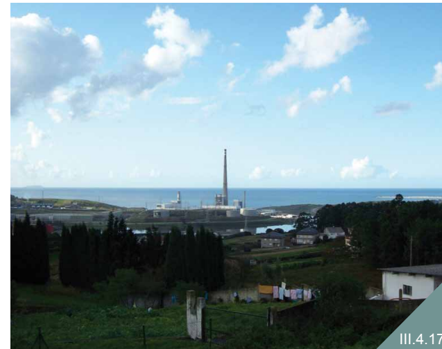
III.4.17 Central térmica de Sabón.
