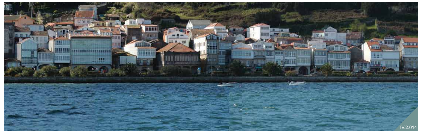
Muros. A Coruña
