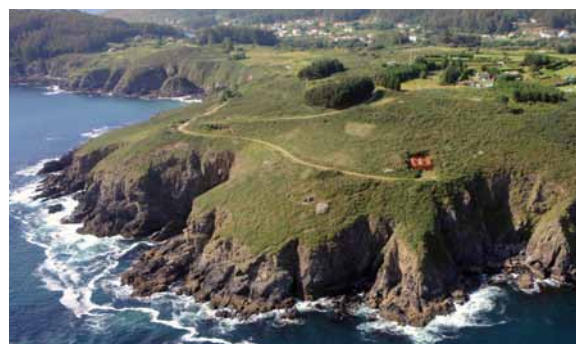
Instalación militar en Punta Avarenta.
