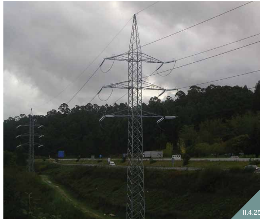
II.4.25 Liña de Alta Tensión en paralelo con infraestrutura viaria, na provincia de Pontevedra.
