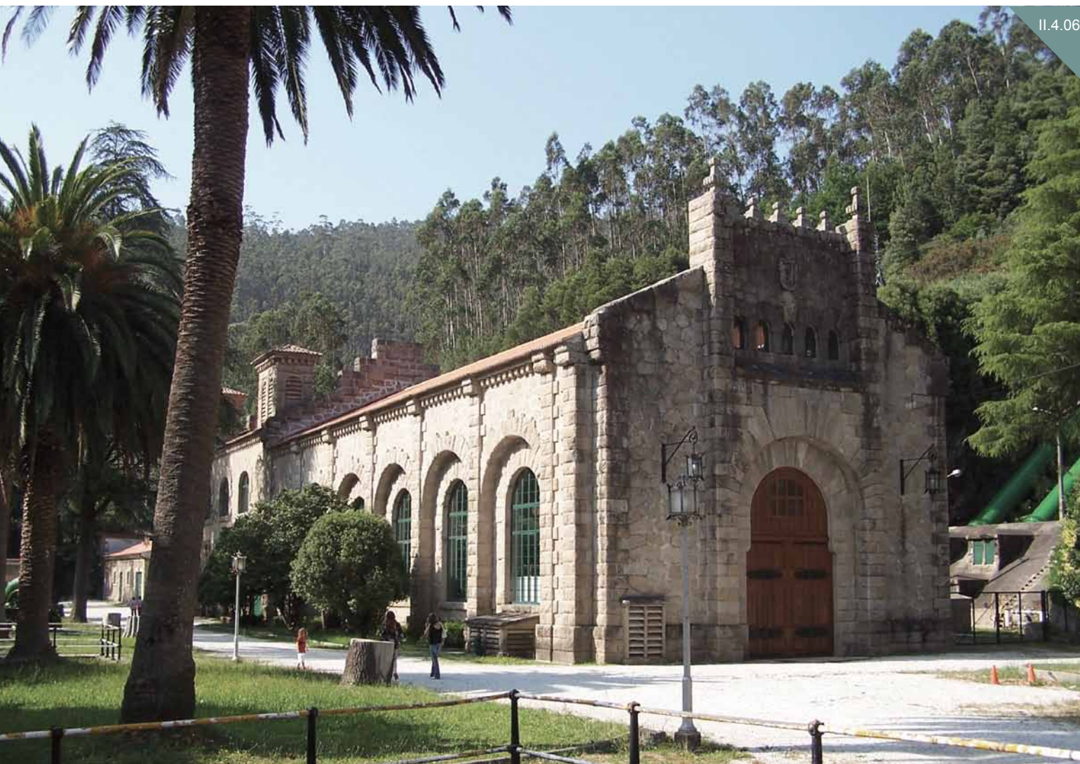
Central Hidroeléctrica de Tambre (Noia).
