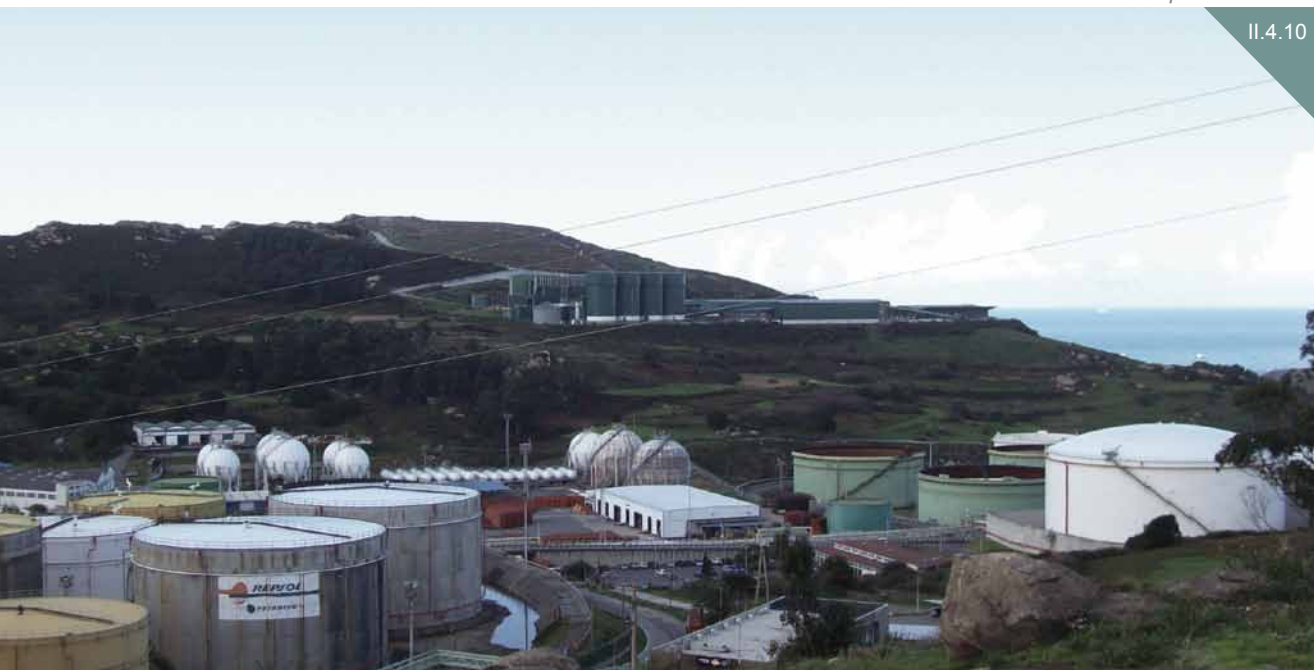
Refinería de Repsol. A Coruña.
