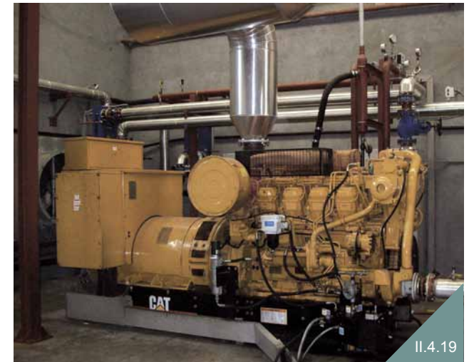
Instalación de Coxeración.
