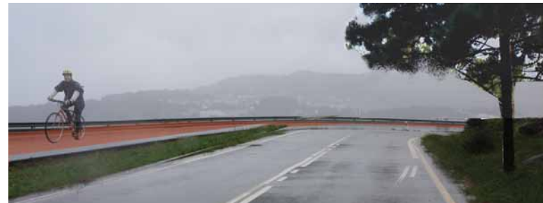
tramo general de la ciclovía. Separación mediante superficie vegetal
