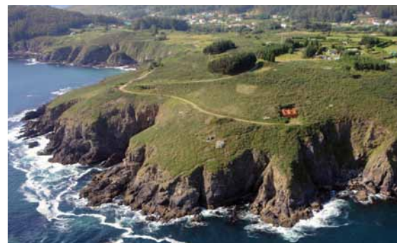
instalación militar en Punta Avarenta
