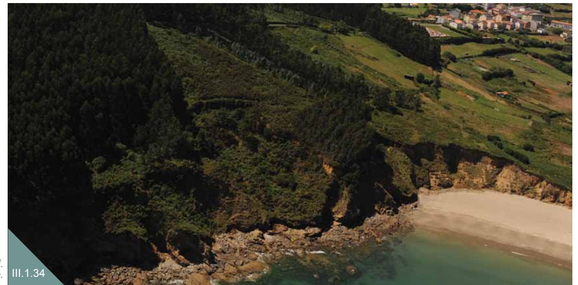
Deslizamiento Rotacional. Cariño.
