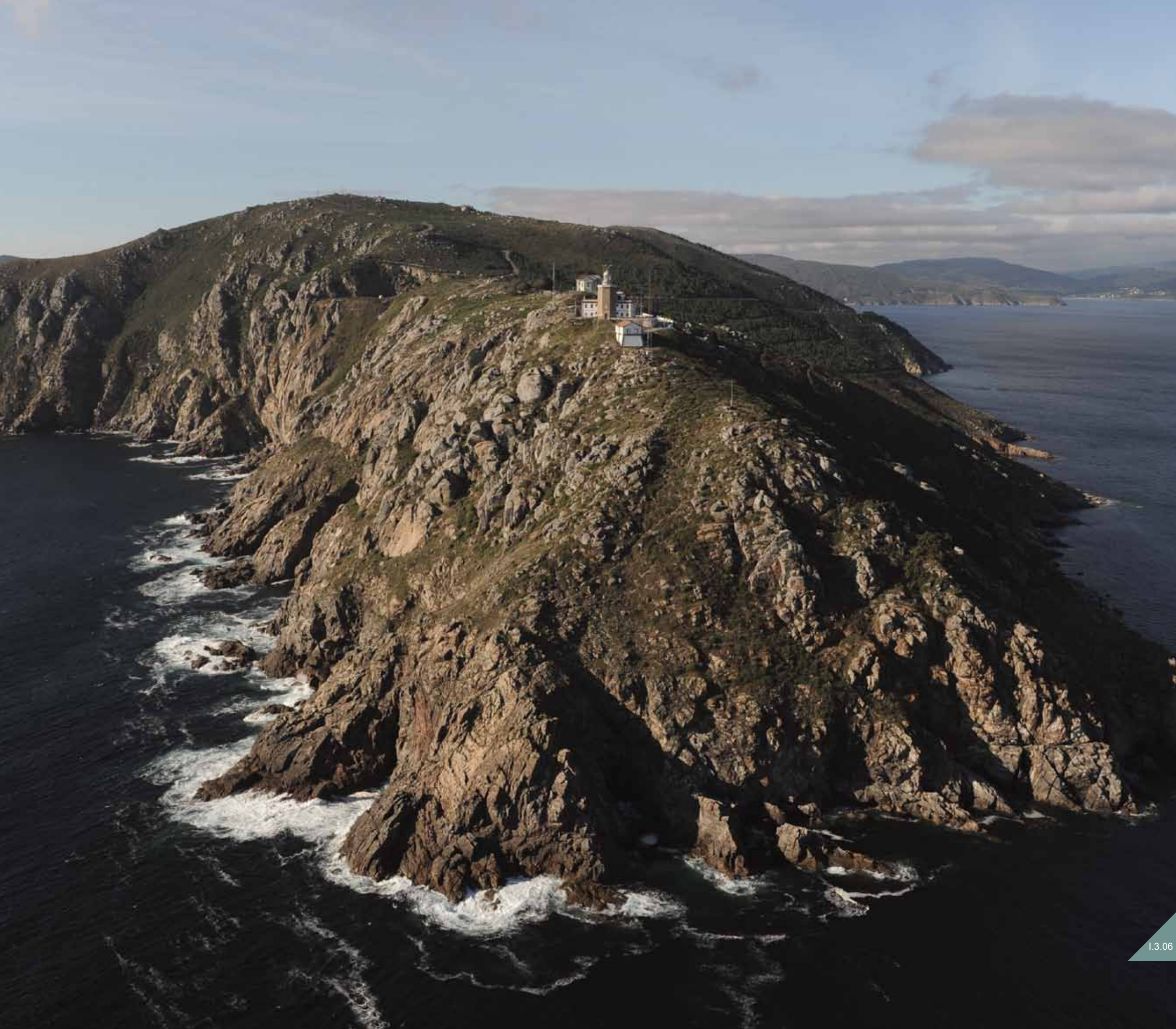
Faro de Finisterre. Seo de Corcubión. Costa da Morte.
