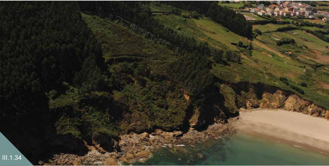
Escorregamento Rotacional. Cariño.
