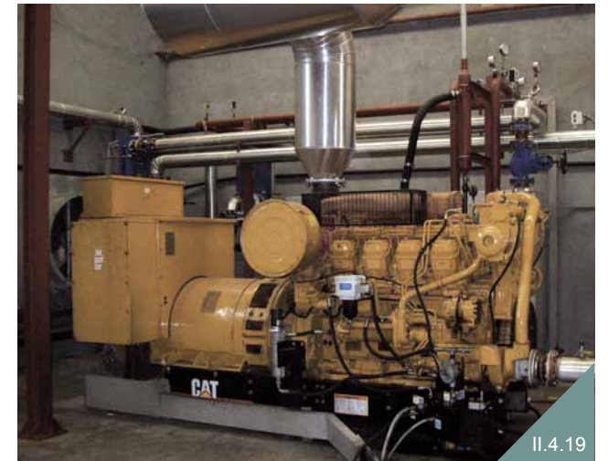
Instalación de Coxeración.
