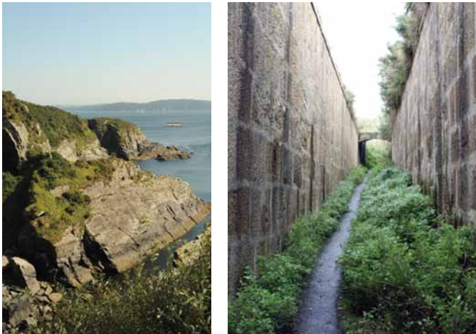
vista y acceso de los tuneles de la Bateria de Punta Segao
