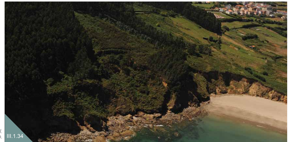
Deslizamiento Rotacional. Cariño.
