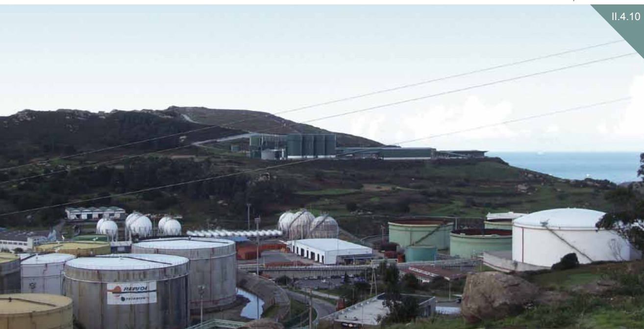
Refinería de Repsol. A Coruña.
