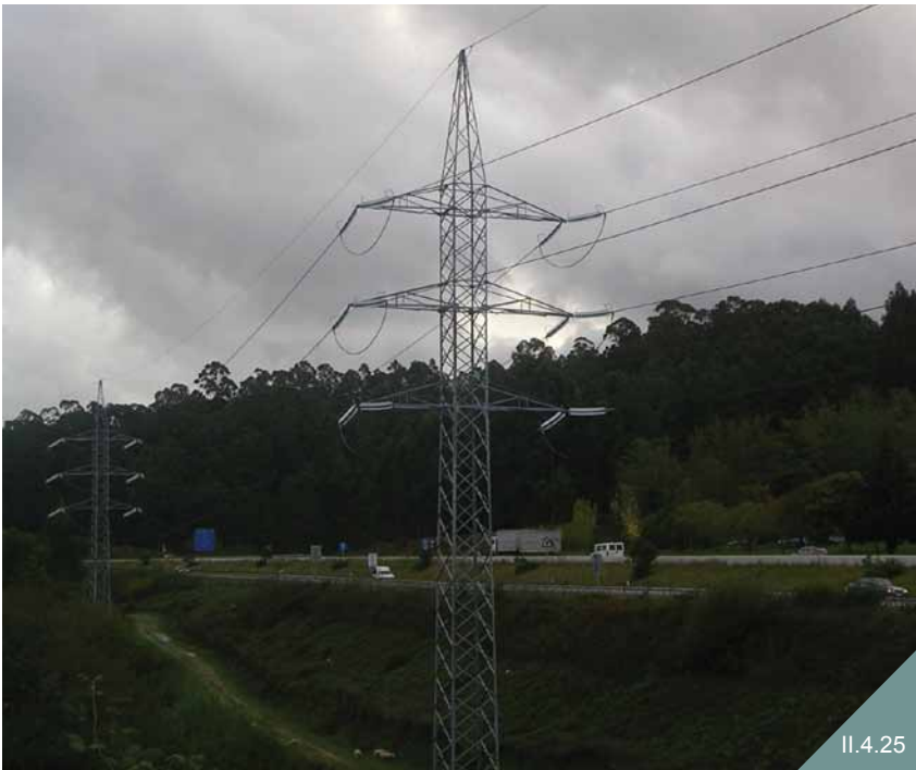
Línea de alta tensión en paralelo con infraestructura viaria.
