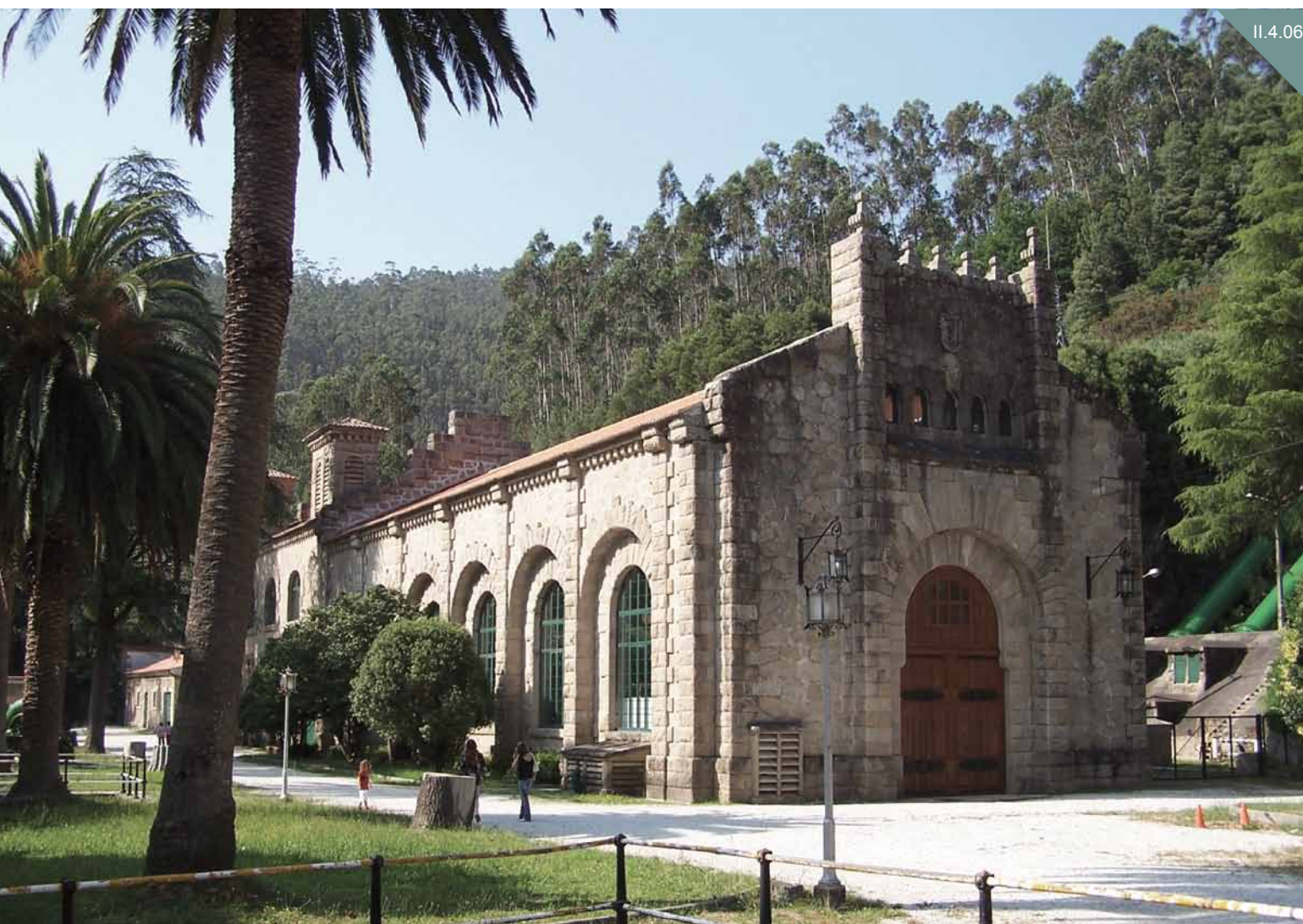
Central hidroeléctrica de Tambre. Noia.
