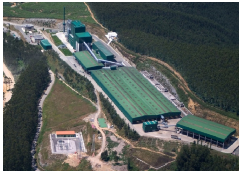
Planta Integral de tratamiento de residuos. Meruelo
